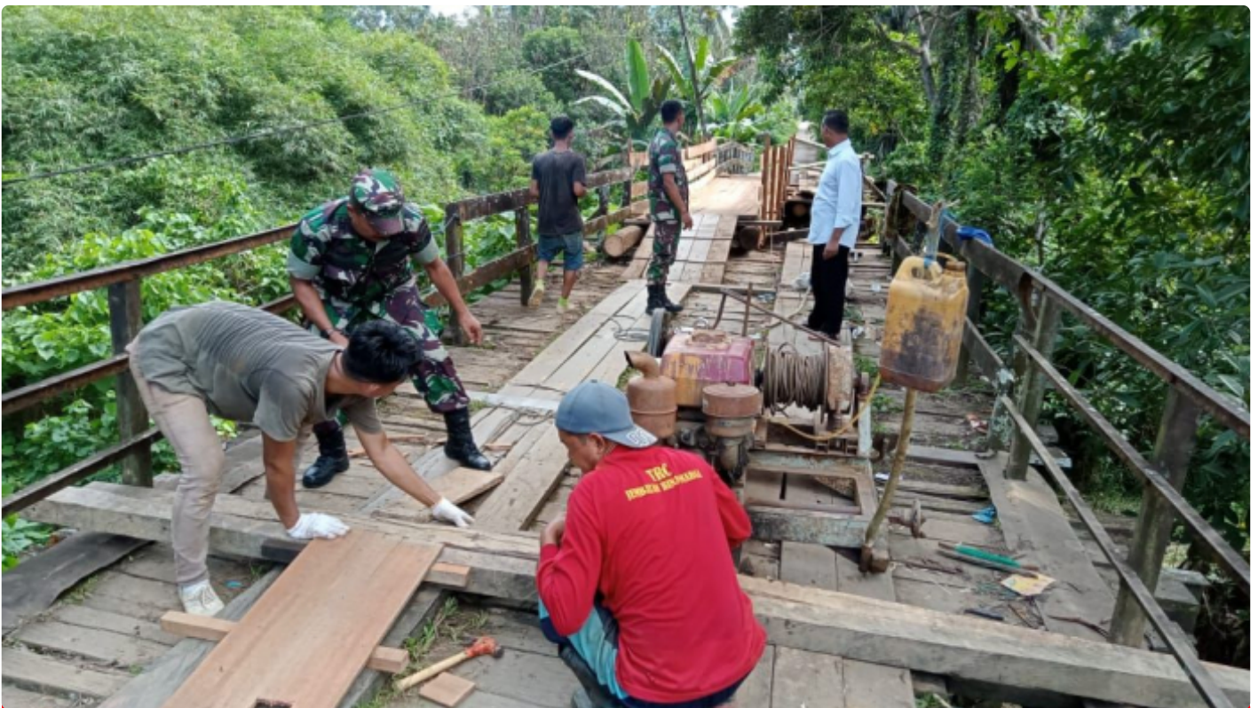
Babinsa Koramil 1008-01/Muara Uya Ikut Gotong Royong Perbaiki Jembatan
