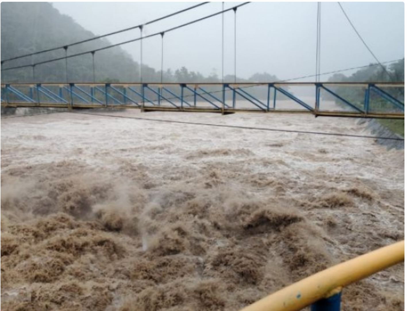
Bendungan Tabo-Tabo capai ketinggian 5 meter
