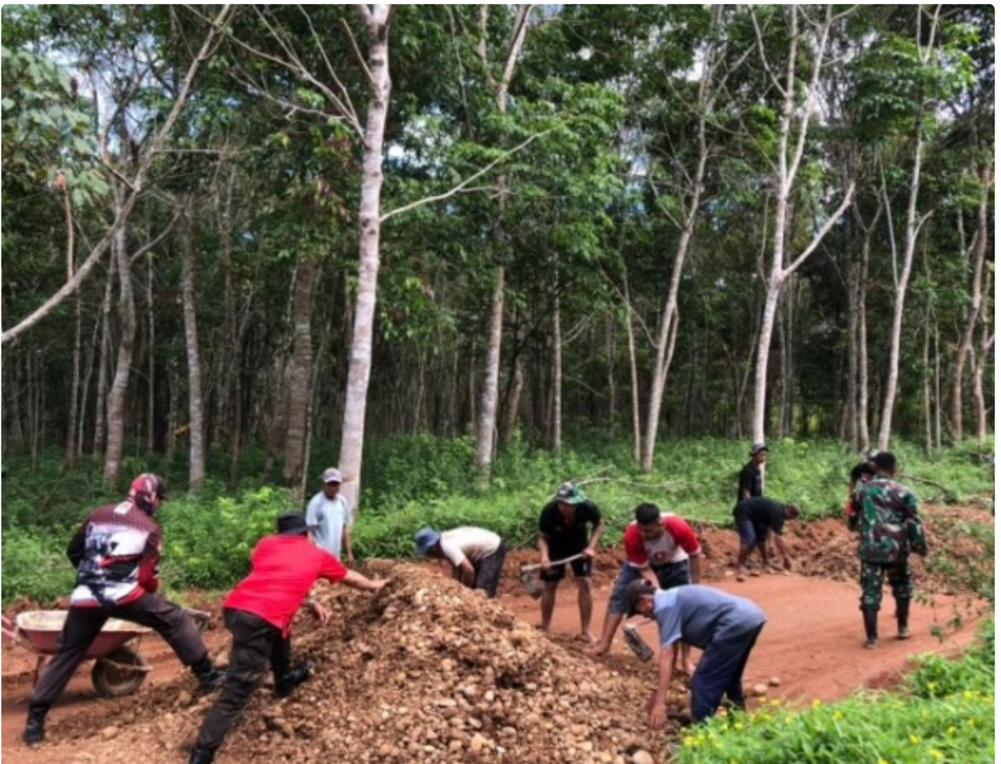
Anggota Satgas TMMMD ke-113 Kodim 1006/Banjar dan Warga Gotong Royong Uruk Jalan
