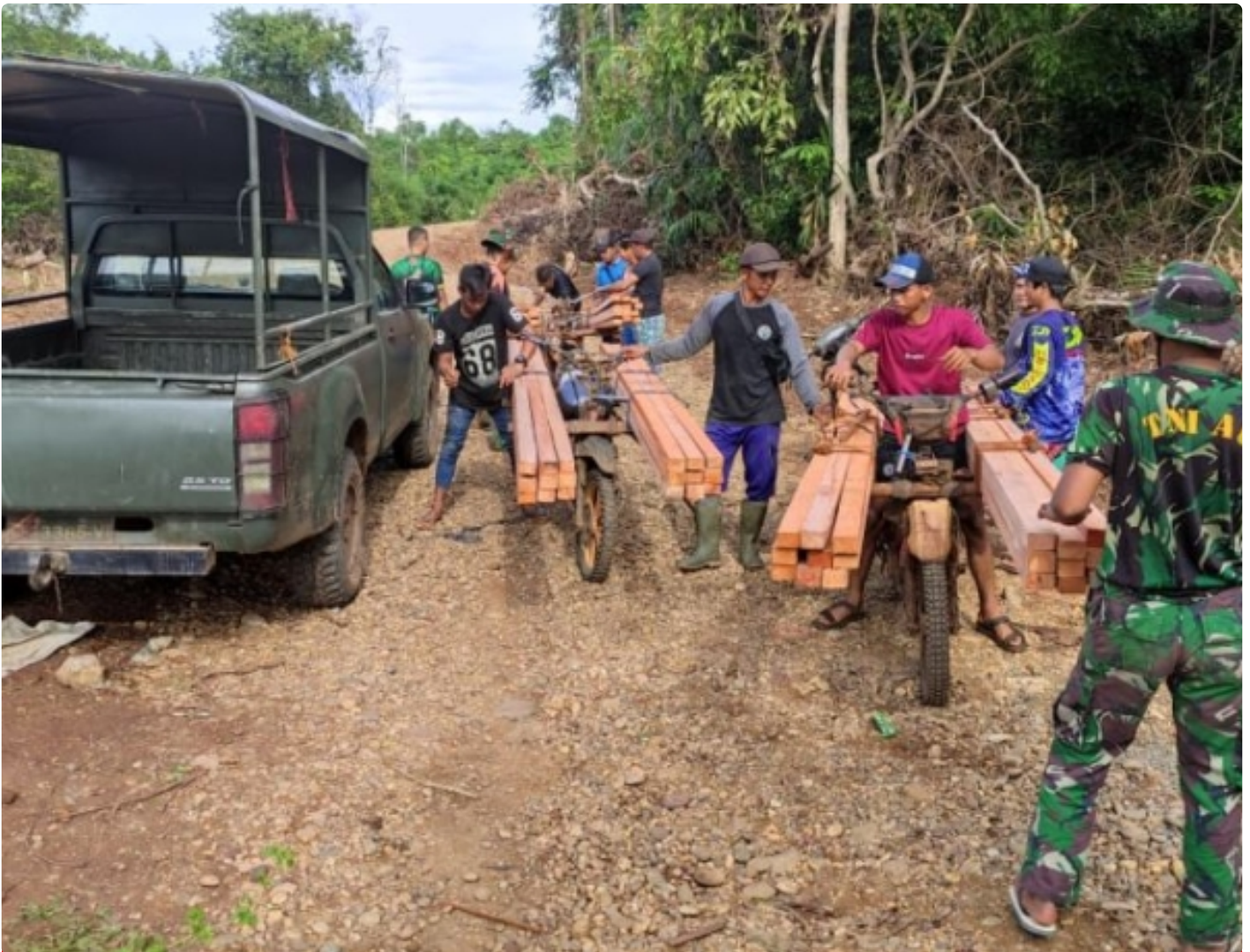
Warga Bantu Bawa Balok Kayu Untuk Jembatan
